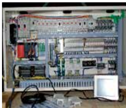
制御盤内配置
