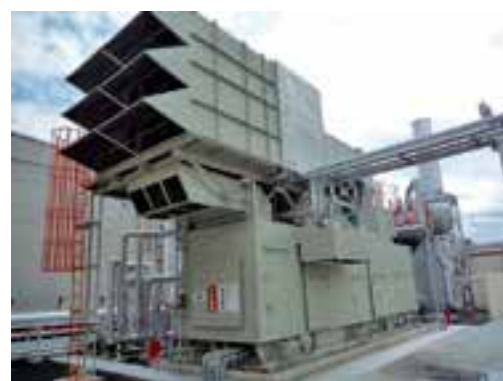
ガスコージェネレーション ガスタービン設置例
