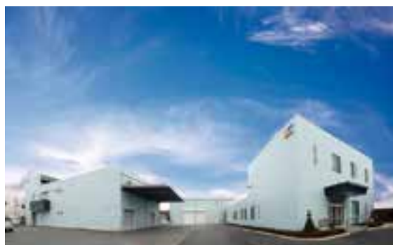
本社工場・事務所棟
