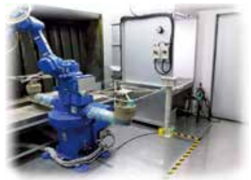
塗装ロボット及び除塵設備
