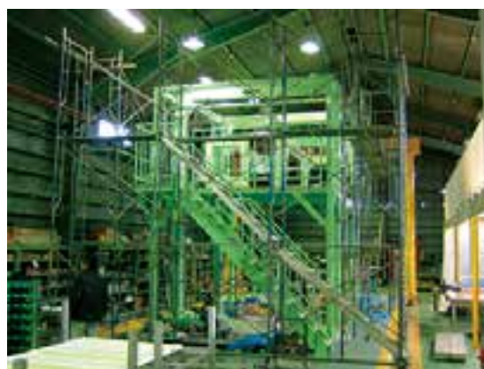
鉄骨架台設計製作据付
