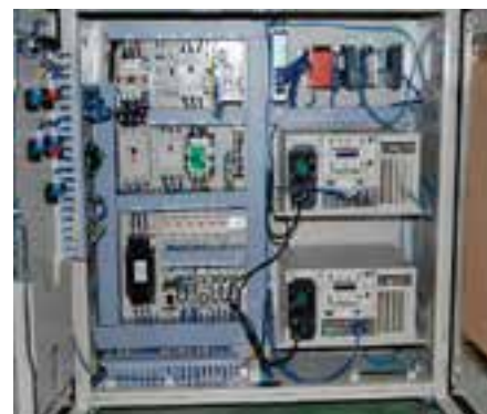
制御盤内配置
