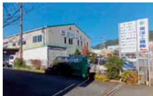
本社工場 事務所棟
