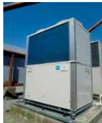
ガスヒートポンプエアコン設置例
