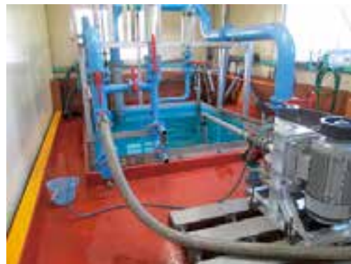
ポンプ性能試験
