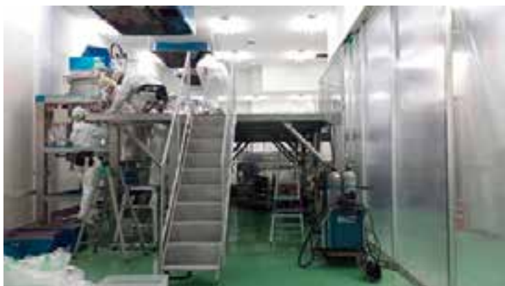
クリーンルーム施工
