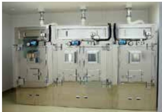
放射性薬剤製造装置
