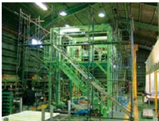
鉄骨架台設計製作据付
