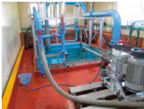
ポンプ性能試験
