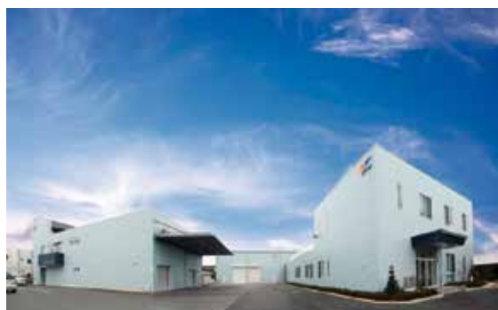
本社工場・事務所棟
