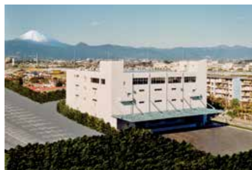
物流事業 物流倉庫
