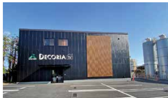
図 3 本社工場外観
