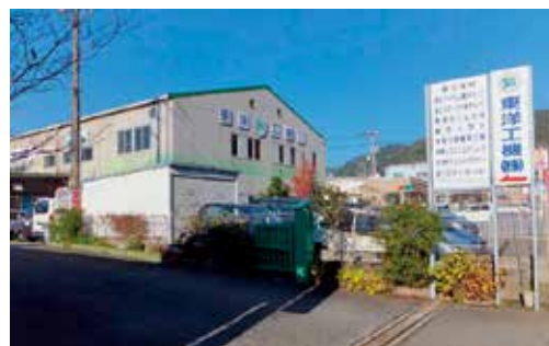
本社工場 事務所棟
