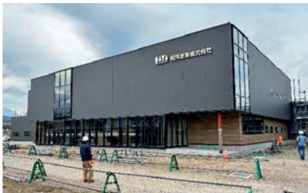
新工場外観図（建設中）
