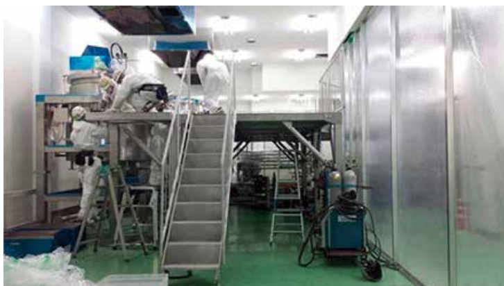
クリーンルーム施工
