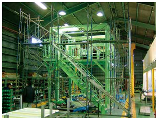
鉄骨架台設計製作据付
