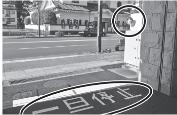
道路上に一旦停止の文字表示とミラーを設置
