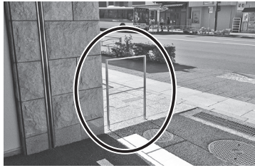
安全対策のための柵も設置
