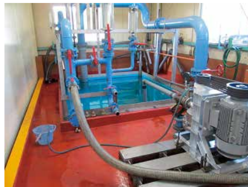
ポンプ性能試験
