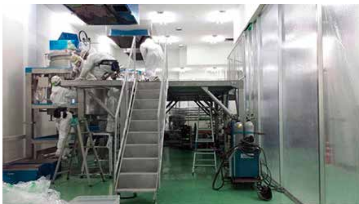
クリーンルーム施工
