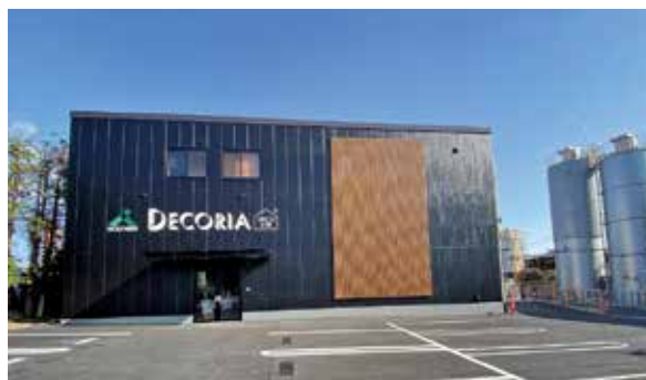
図 3 本社工場外観
