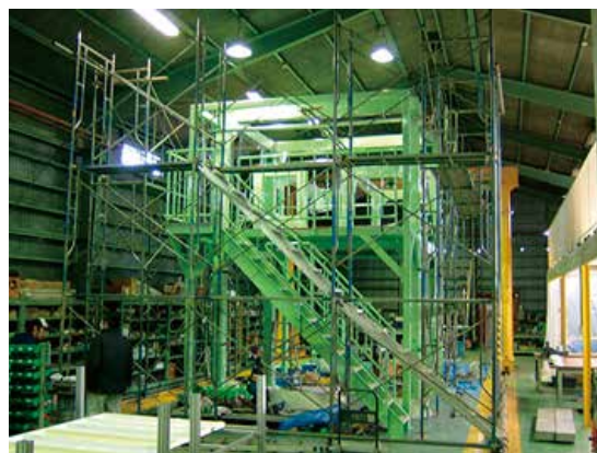
鉄骨架台設計製作据付
