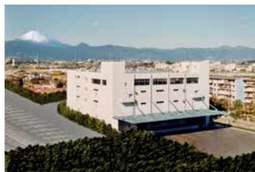
物流事業 物流倉庫
