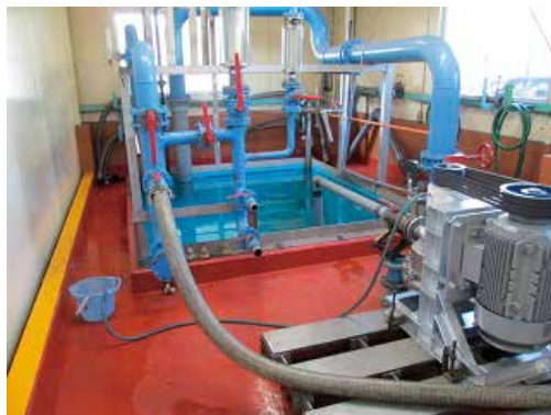
ポンプ性能試験
